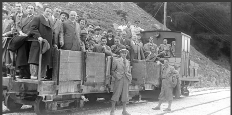
Die historischen Transportstrukturen des Laaser Marmors werden heute noch genutzt.
